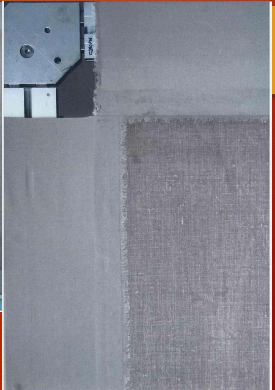
Pose de bandes de tension en polyester et mise en tension sur bâti provisoire
